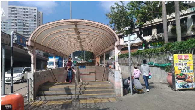
C1 出口外部。
